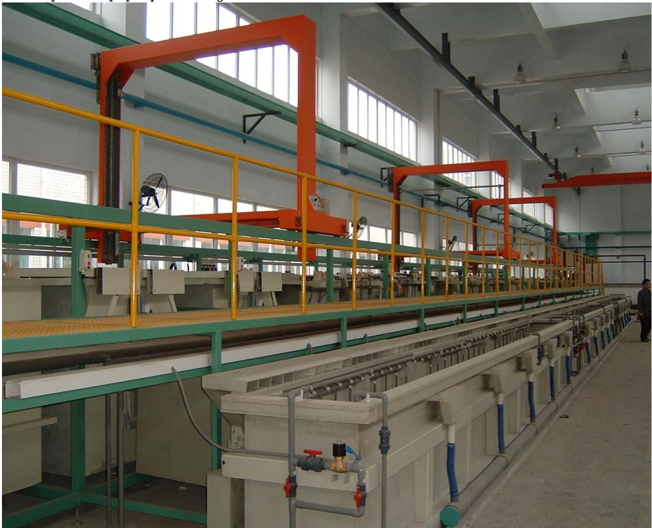
El zinc placas equipo. planta de galvanizado.
