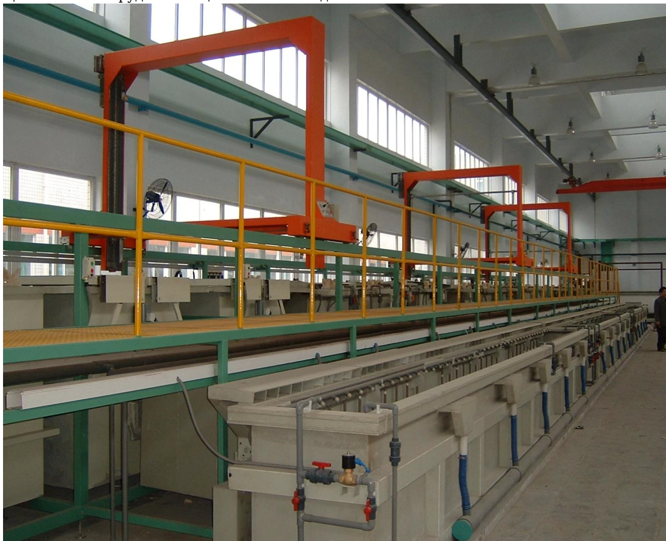
Цинкование оборудование. цинкование завода.
